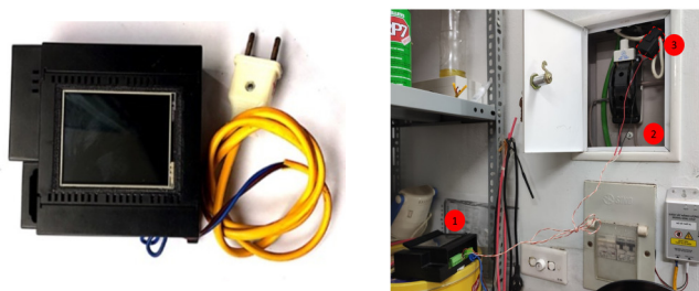
Hình 5. Lắp đặt thiết bị đo và phân tích sóng hài tại cầu dao tổng của công trình
