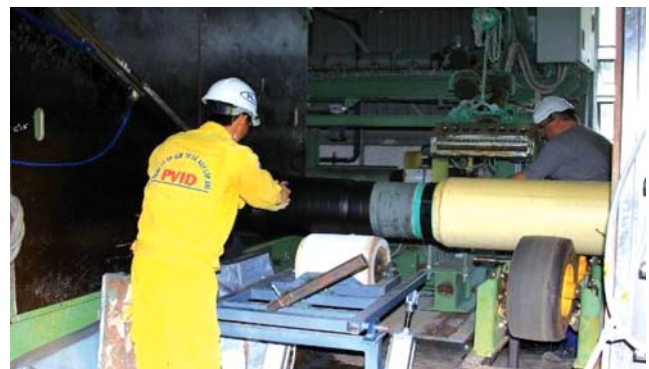
Ảnh 3. Các ống cách nhiệt sau đó được gia cố thêm lớp vỏ HDPE chống thấm nước
