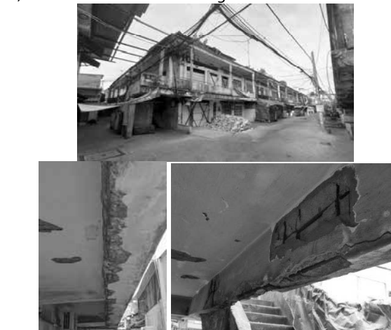
Hình 23. Xây dựng từ khoảng 1980-1985 (phường 14, quận 6), cư dân của 80 hộ gia đình nơi đây đã bắt đầu được di dời đến nơi tái định cư từ cuối năm 2018
