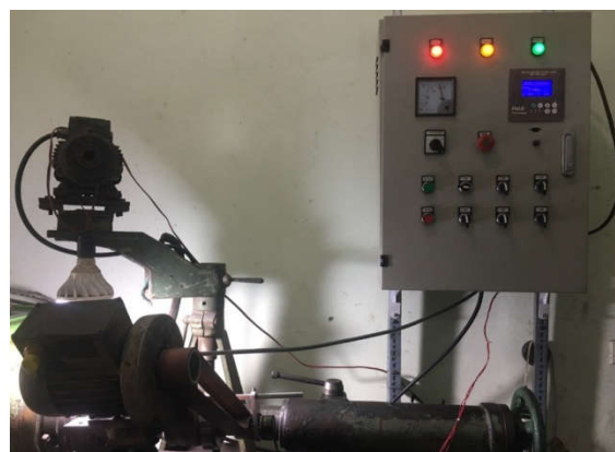
Hình 10. Lắp đặt kết nối tủ điều khiển với máy 15811
